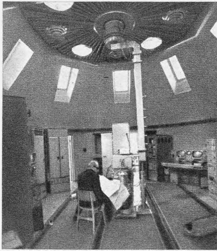
Bild 3. Der im Sockel der Orbita-Station untergebrachte Gerätesaal mit Empfangs- und Sendeanlagen (Station Nowosibirsk)
