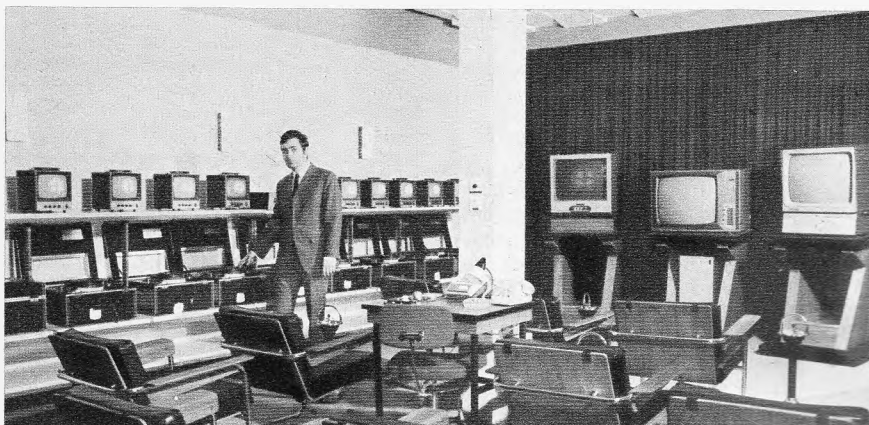
Zehn Shibaden-Videorecorder fertigen gleichzeitig zehn Schwarzweiß-Magnetbandkopien eines Werbefilms für das „Laden-Fernsehen“ an
